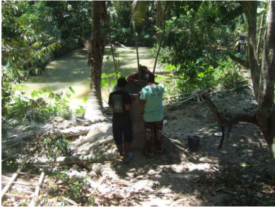
๑๑. โครงการขุดบ่อน้ำตื้น หมู่ที่ ๗
