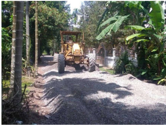
๘. โครงการก่อสร้างถนนลาดยาง ซอยสุวรรณ ๒ หมู่ที่ ๗
