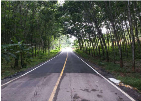
๗. โครงการก่อสร้างถนนลาดยางสายกอบแก้ว-เขาน้อย หมู่ที่ ๖
